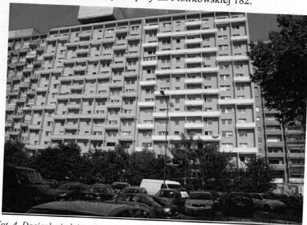
Fot. 4. Docieplenie ścian zewnętrznych i kolorystyka elewacji budynku przy ul. Piotrkowskiej 204/210
